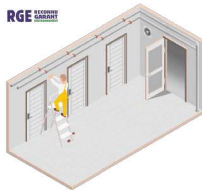
ISOLATION D'UN RÉSEAU HYDRAULIQUE
